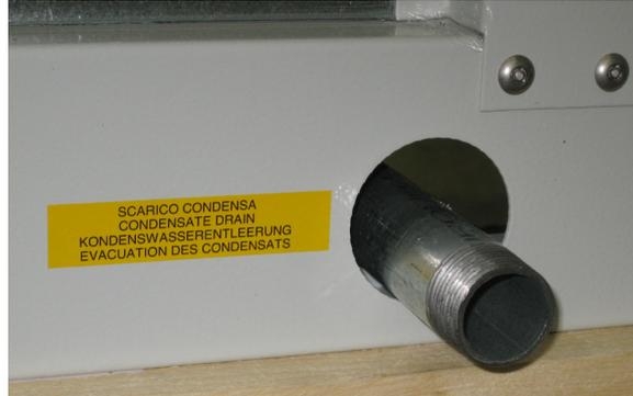
Fig. 9 Raccordement au bac à condensats
